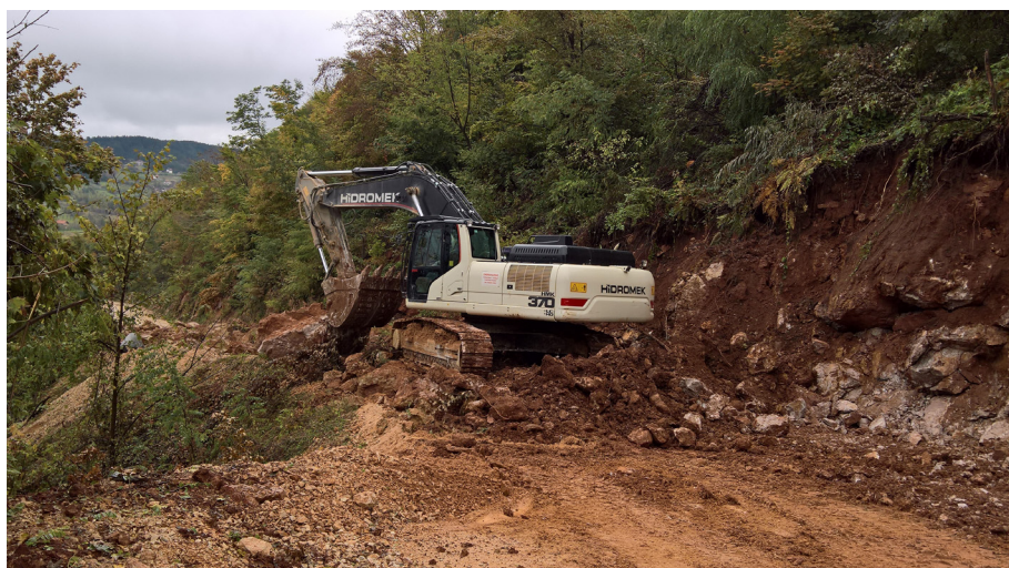
Proširivanje puta pored klizišta
