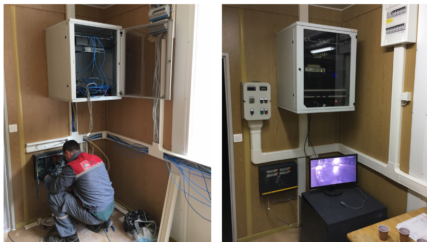
Kabliranje unutrašnjosti novog kontejnera
