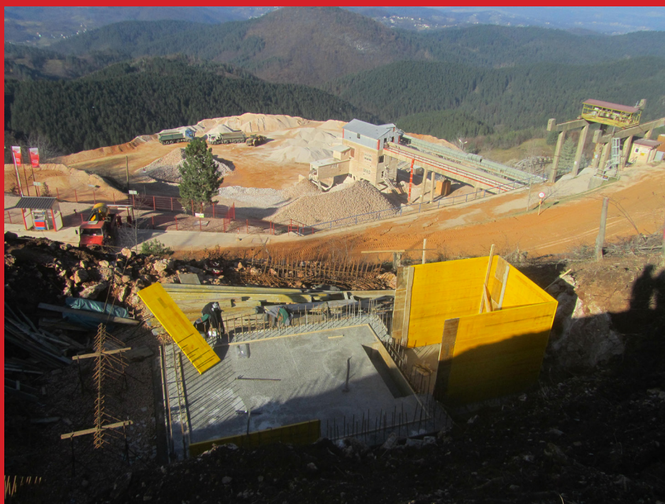
Izgradnja novog rezervoara za vodosnabdijevanje
