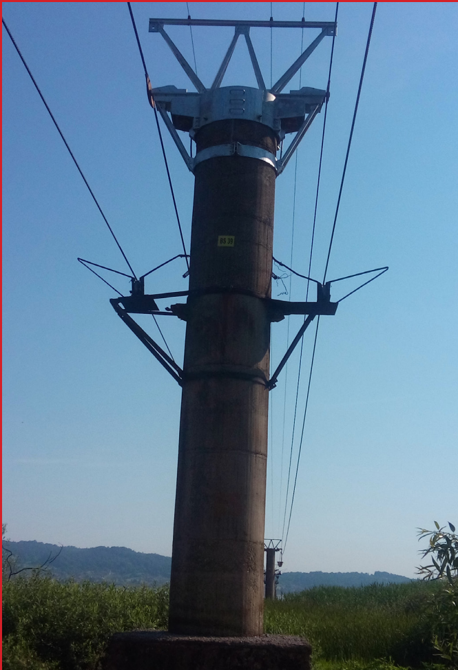
Metalna nadvišenja na betonskim stubovima
