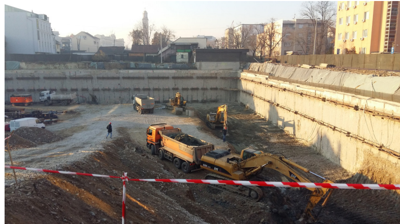
Izgradnja objekta City Mall u Banja Luci
