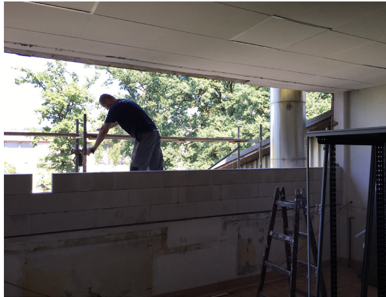
Građevinski radovi u server sobi
